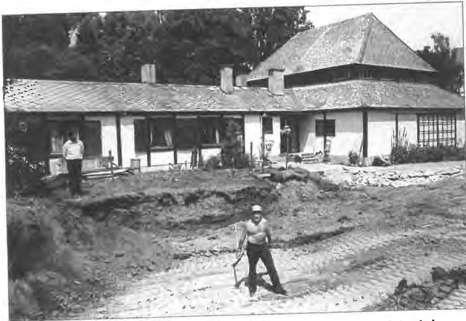
Wo nur eine Grube mit einem einsamen Bauarbeiter zu sehen ist, wird sich bald stolz das neue Gemeindehaus erheben
