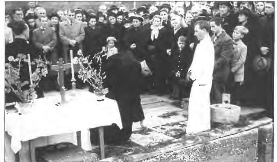
Grundsteinlegung für die Wertinger Kirche 1949. In der Mitte der damalige Wertinger Pfarrer Kirchenrat Bessert (mit Hammer), rechts von ihm der Maurer Johann Eser.
