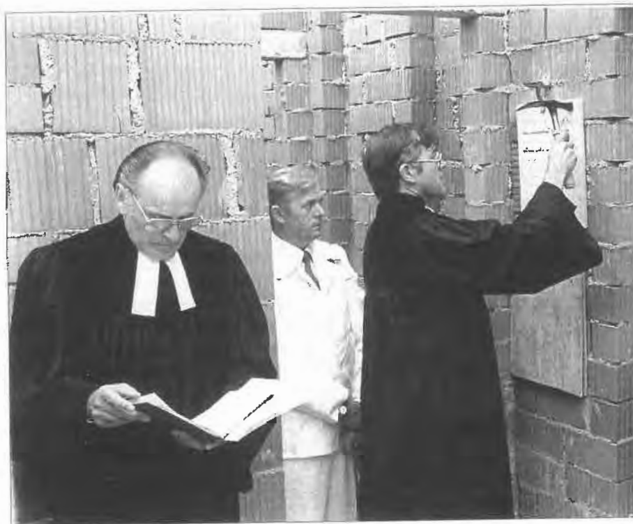
Pfarrer Waldmann und Pfarrer Harz im Rohbau des Gemeindehauses
